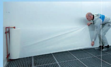
Horizontal von unten nach oben verkleben. Bahnen leicht überlappend anbringen.
