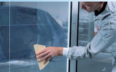
Mit dem Raker das Wasser unter der Folie nach außen drücken.
