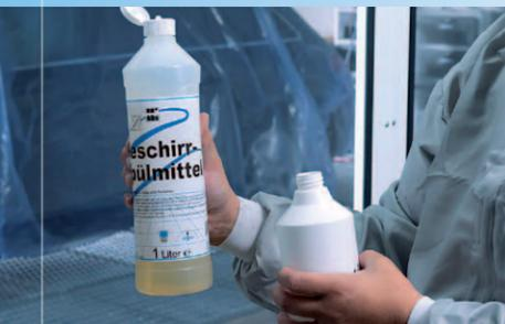
Transparente Folie nass aufziehen, die Zugabe eines Netzmittels erleichtert das Positionieren.
