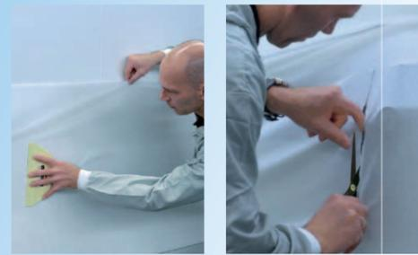
Mit dem Raker glatt streichen, mit der Scotch™ Titanium Schere leicht schneidbar.
